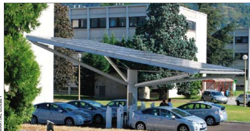
Parking solaire sur le site du Commissariat à l'énergie atomique de Grenoble.
