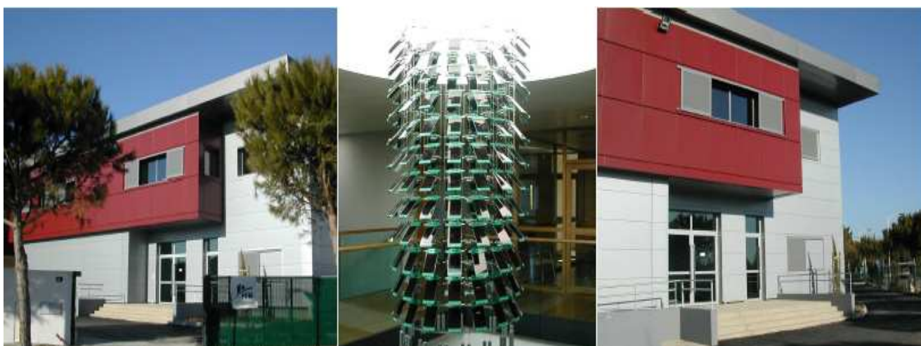
Construction d'un immeuble de bureaux : siège de la FFB du Gard
