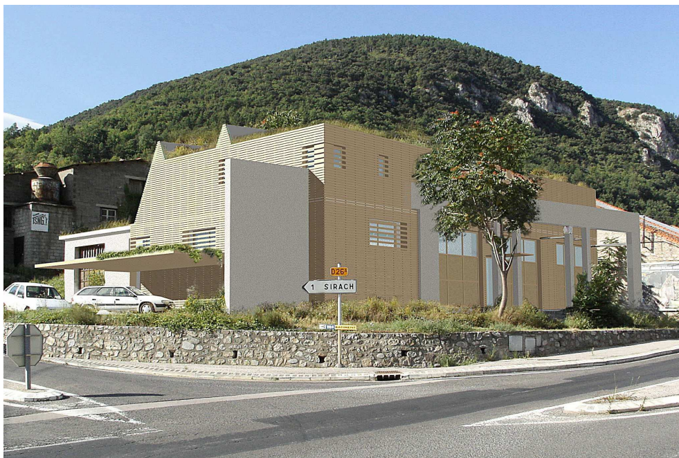
Construction de bureaux (SCI DORONIC) à Ria (Languedoc Roussillon)
