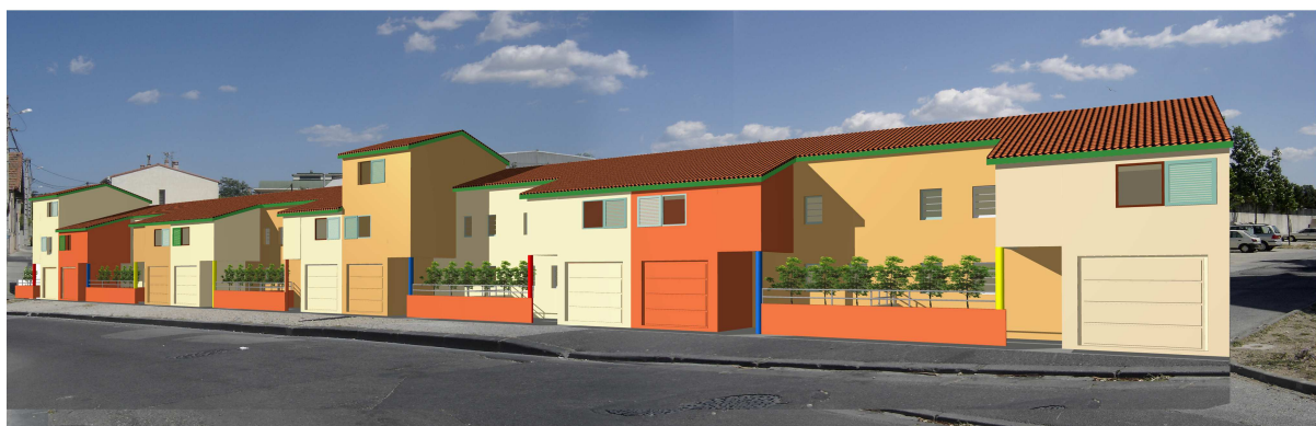
Construction de 14 maisons individuelles - groupées- ; OPAC Perpignan Roussillon ; Perpignan
