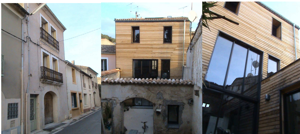
Figure 8 : Réhabilitation d'une maison à Cournonterral (Languedoc Roussillon)
