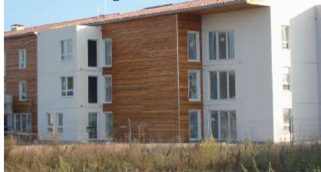
Construction 24 logement collectifs Maître d'Ouvrage : Kalelithos (34)
