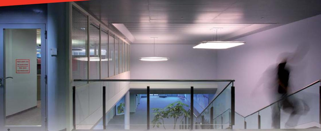
L'éclairage artificiel doit permettre d'assurer des valeurs d'éclairement par exemple d'au moins 20 lux en tout point du cheminement extérieur accessible, 100 lux en tout point des circulations intérieures horizontales, 150 lux en tout point de chaque escalier:
