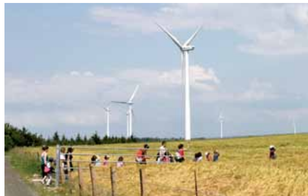
Visite scolaire du parc éolien d'Ally (Auvergne) comprenant 26 éoliennes de 1,5 MW et de 122 m de haut.
