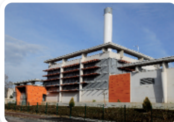
Chaufferie bois du quartier du Château Blanc à Saint-Etienne- du-Rouvray (76)
